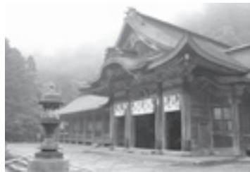
大神山神社奥宮 (令和7年度まで屋根の葺き替え工事中)
